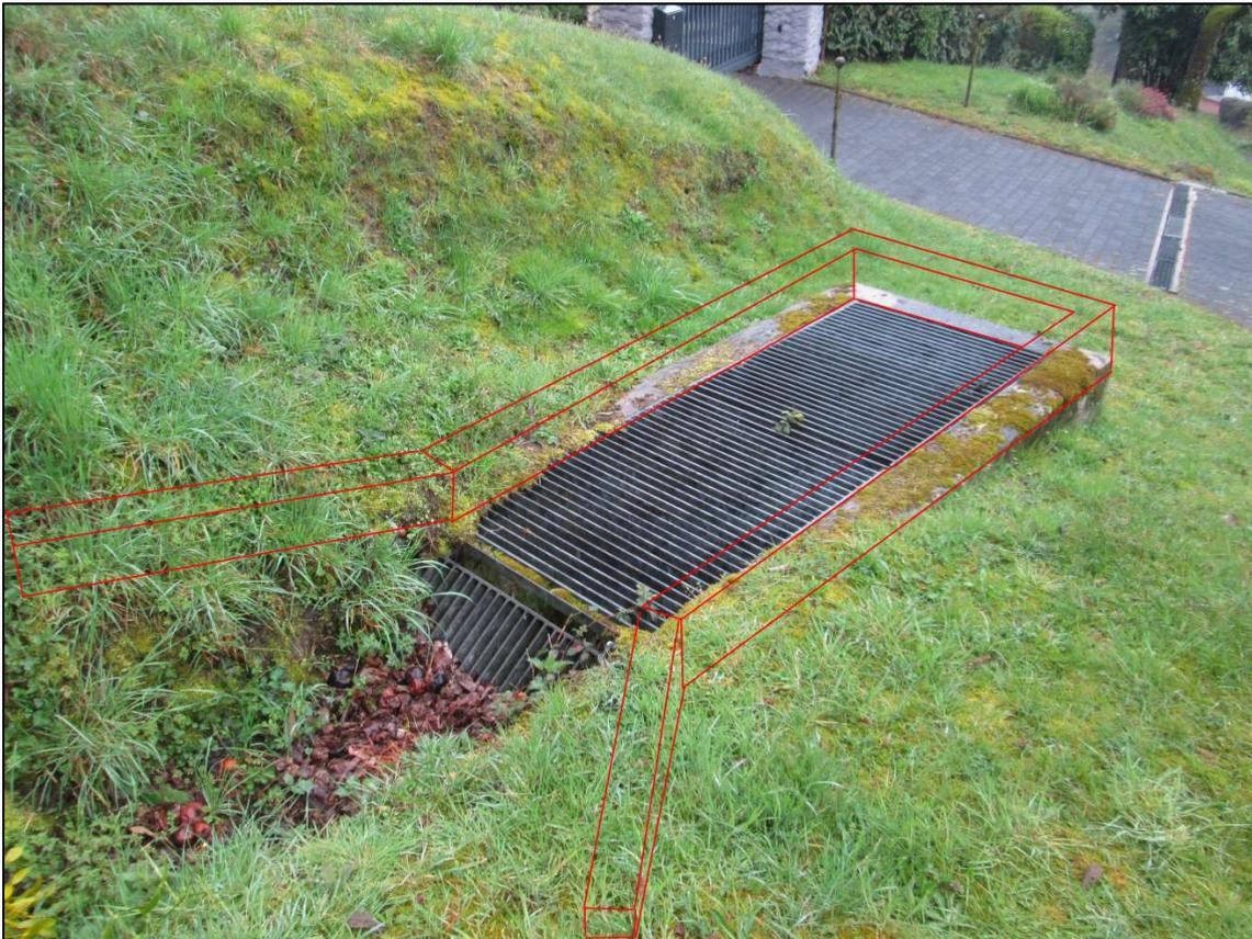
Abbildung 75: Visualisierung Einlaufbauwerk mit Überstaumöglichkeit
