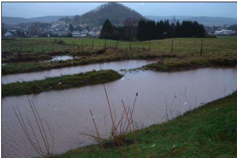
Abbildung 88: Ausführungsbeispiel kaskadenförmiger Rückhalt in einer Tiefenlinie
