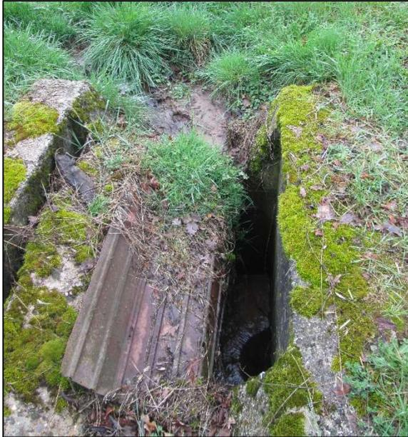
Abbildung 81: beschädigtes Einlaufbauwerk
