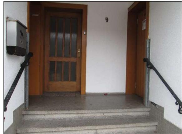
Abbildung 62: Beispiel mobile Schutzmaßnahmen
