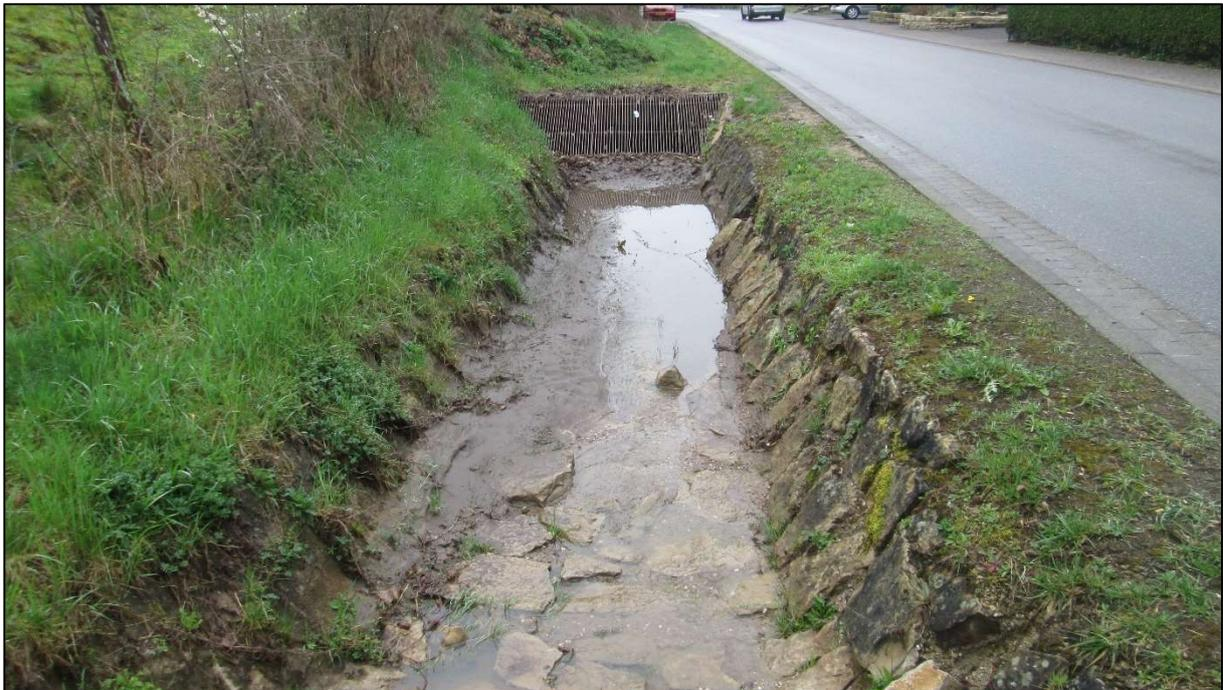
Abbildung 67: Einlaufgitter am Beginn der Verrohrung
